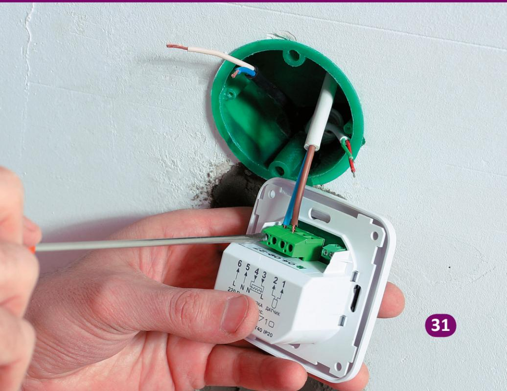
СЕРВИСНАЯ КОРОБКА ПРЕДНАЗНАЧЕНА ДЛЯ ПОДКЛЮЧЕНИЯ К ОДНОМУ ТЕРМОРЕГУЛЯТОРУ ОТ 2 ДО 4 ПОЛОС НАГРЕВАТЕЛЬНОЙ ПЛЕНКИ.
