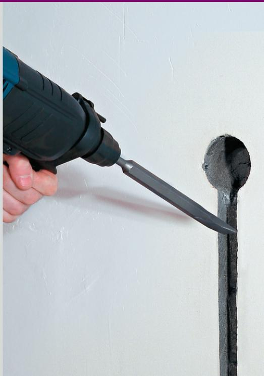
СДЕЛАЙТЕ УГЛУБЛЕНИЯ В ПОЛУ В МЕСТАХ РАСПОЛОЖЕНИЯ СОЕДИНИТЕЛЬНЫХ КОРОБОК, ДАТЧИКА И УСТАНОВОЧНЫХ ПРОВОДОВ.
