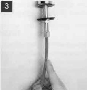
В гайку (Е) проденьте пластиковую трубку (рис. 1). Пистон (Ж) вставьте внутрь трубы до упора (рис. 2). Закрутите на резьбовой шток крана гайку (рис. 3).
