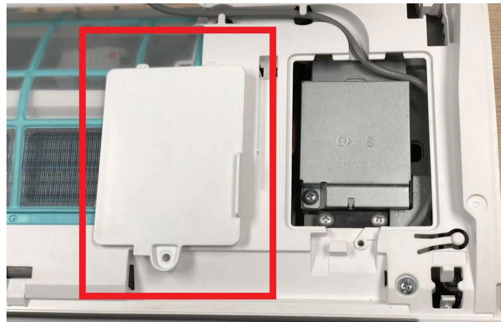
**5.** От дисплея (виден на внутренней стороне верхней панели, фотография из пункта 2.) отходит кабель в изоляции серого цвета, расстыкуйте разъем на этом кабеле под крышкой клеммников.
