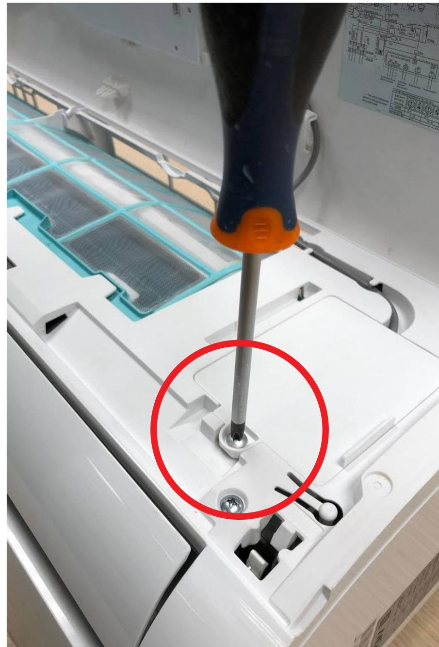
**4.** Снимите крышку клеммников.
