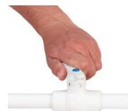
8. Откройте запорный вентиль перед системой очистки воды и убедитесь в отсутствии протечек в местах соединений. В течение 3-х часов после установки картриджа, периодически проверяйте систему очистки воды на наличие протечек в местах соединений.
