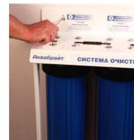
4. Если необходимо, прикрепите раму системы очистки к стене или повесьте на стену в месте установки.
