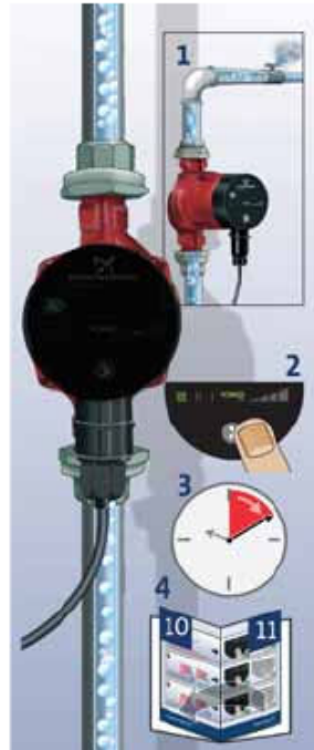
Рис. 12 Удаление воздуха из систем отопления
