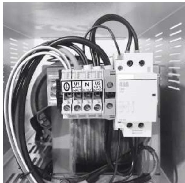
**ВНИМАНИЕ!** Подключайте фазу и нейтральный провод к соответствующим клеммам, а также не путайте соединение входа с выходом и наоборот, так как это может привести к серьезному повреждению стабилизатора.
