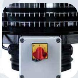
Вентиляторы поставляются укомплектованными сервисными выключателями
