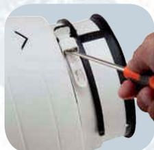
При помощи отвертки, ослабьте защелку.
