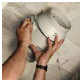
Установите корпус вентилятора.
