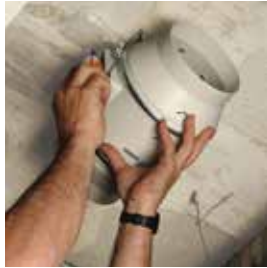
Установите блок двигатель-крыльчатка.
