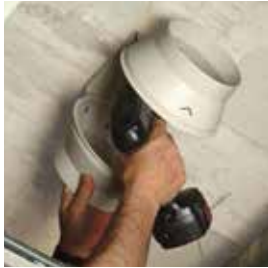
Закрепите основание вентилятора.
