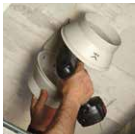
Закрепите основание вентилятора.
