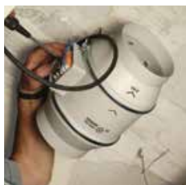
Подключите вентилятор к сети электропитания.
