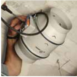
Подключите вентилятор к сети электропитания.
