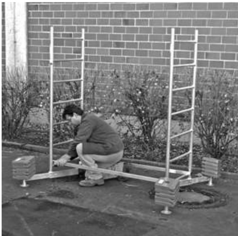
Базовая конструкция с первой и второй надстройками
