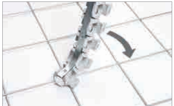
Рис. 4-49 Закрепить поворотную клипсу вращательным движением
