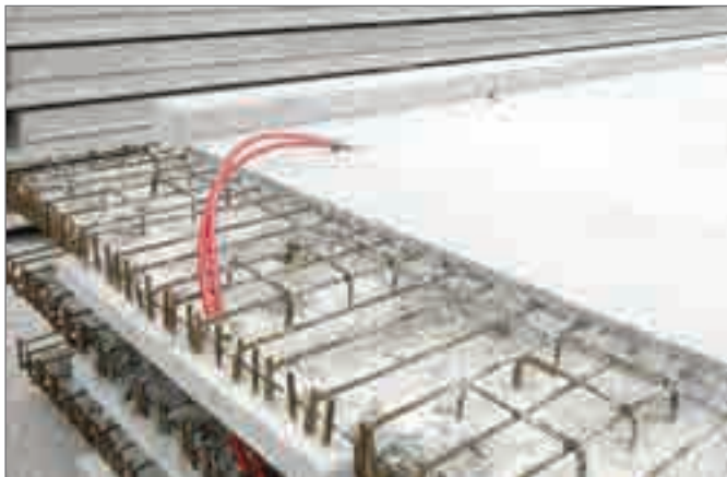
Рис. 9-4 Система REHAU ВКТ из полуготовых модулей
