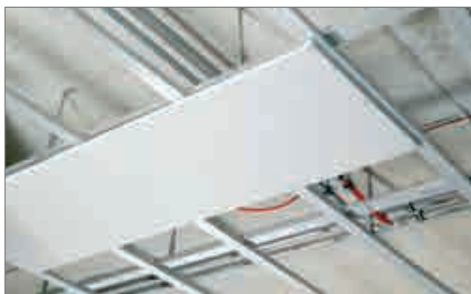
Рис. 5-34 Настенная панель обогрева/охлаждения, смонтированная на потолке
