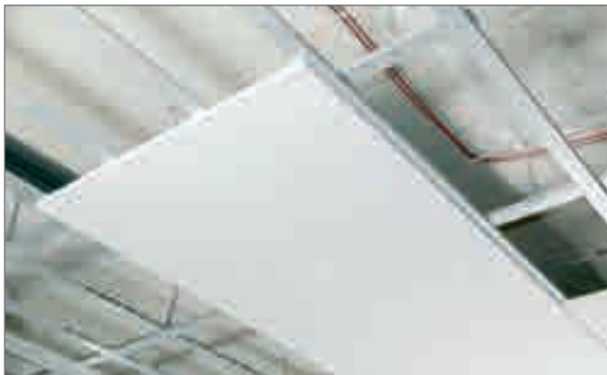
Рис. 5-5 Смонтированный потолочный элемент
