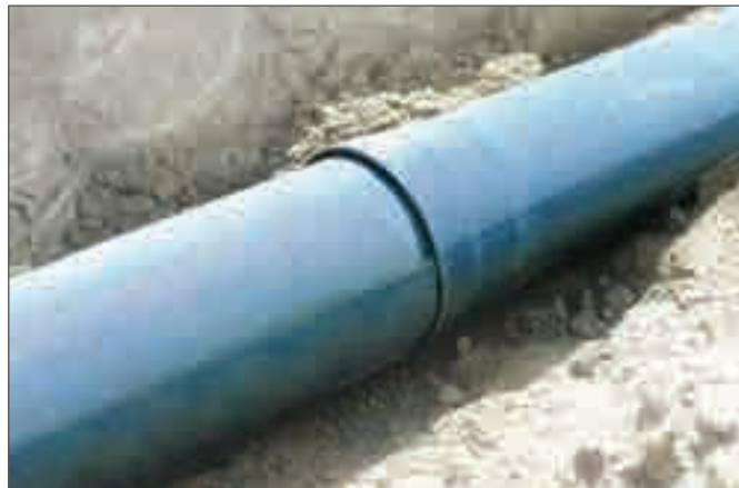
Рис. 13-2 Укладка дренажа на игровом поле
