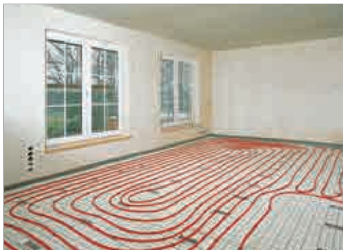
Рис. 4-21 Система крепления труб с помощью гарпун-скоб
