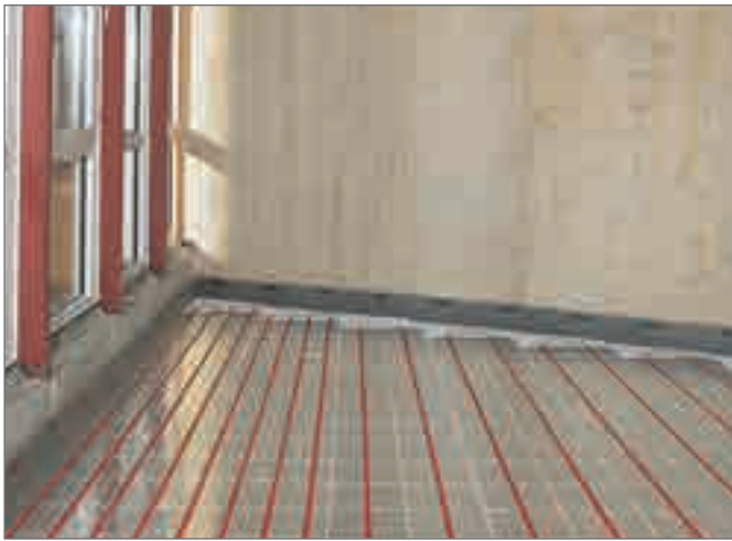
Рис. 4-53 «Сухая» система укладки труб
