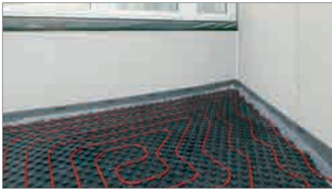
Рис. 4-10 Маты с фиксаторами Varionova с шагозвукоизоляцией 30-2 снизу
