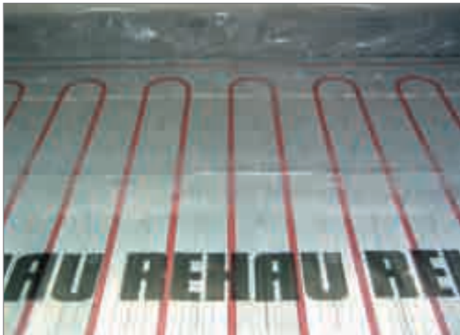
Рис. 4-63 Система укладки труб на теплоизоляционных матах TS-14
